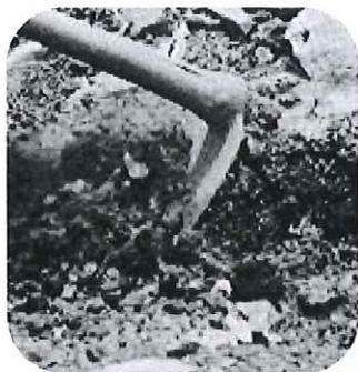
รูปที่ ๑-๓ ขุดหลุมฝังถังขยะเปียก
